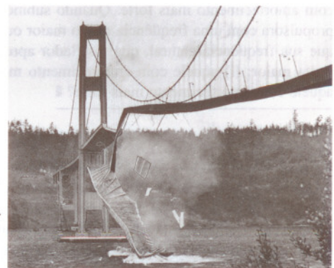
Figura 13.29 A ponte Tacoma Narrows foi destruída quatro meses e seis dias depois da sua inauguração. O vão principal, com 853,44 m de comprimento e 11,89 m de largura, contava com vigas protetoras de aço de 2,44 m de altura dos dois lados. A amplitude máxima das vibrações de torção foi de 35°, e a frequência de ressonância foi de aproximadamente 0,2 Hz.
