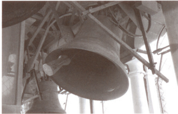
Figura 13.25 Um sino balançando por si só acaba parando de oscilar devido a forças amortecedoras (resistência do ar e atrito no ponto de suspensão).
